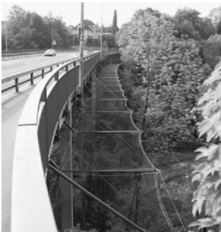
Horizontal auskragendes Schutznetz
