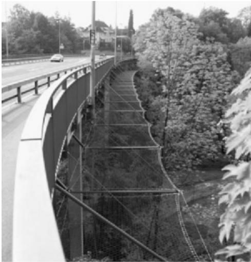
**Horizontal auskragendes Schutznetz**
